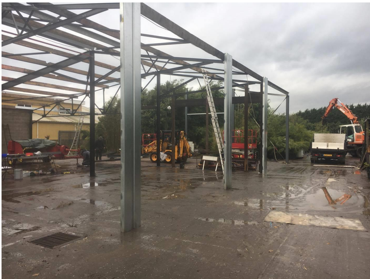
3. Kép. Raktár tetőszerkezetének restaurálása.
